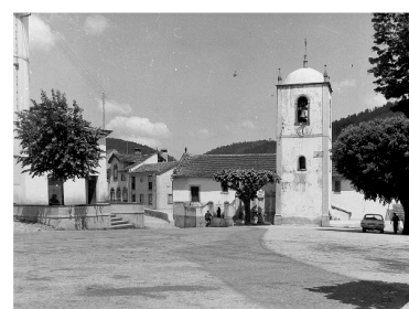
▲ Fig. 05 – Vista da Igreja matriz (1970)
