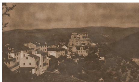
▲ Fig. 24 – Vista do hospital da Misericórdia
