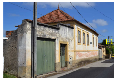
Fig. 07 – Edifício E1 ao fundo
