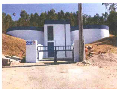
Reservatório de Agrêlo
