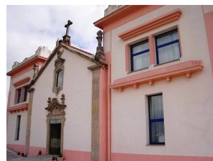
Figura 10 - Capela do edifício 159
