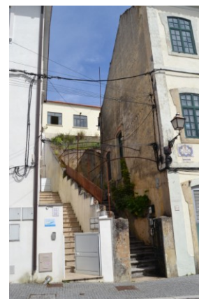
Figura 25 - Empena poente do conjunto de edifícios 44, 45, 46, 47, 48
