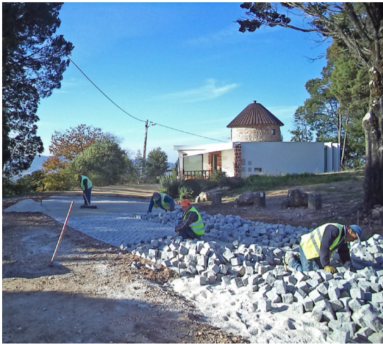
Obras de Pavimentação no Acesso ao Museu do Moinho a decorrer
