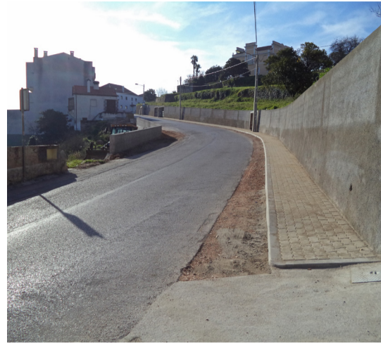
Obras de Beneficiação e Pavimentação na Rua da Estrada Nova, Cheira a decorrer
