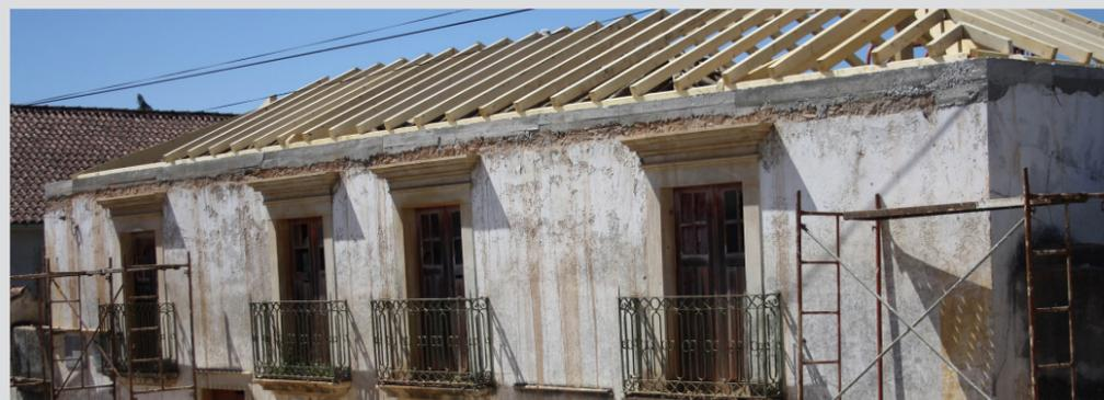
O projeto incide sobre o edifício da Casa António José de Almeida, localizado na União de Freguesias de São Pedro de Alva e São Paio de Mondego, sendo o seu foco a cobertura de telha canudo existente e atualmente em estado de degradação devido às infiltrações de águas pluviais, visando recuperar a cobertura deste edifício com relevância histórica e cultural.
